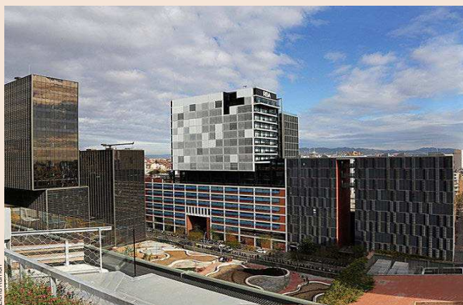
Edificios de oficinas en el distrito tecnológico 22@, en Barcelona.
